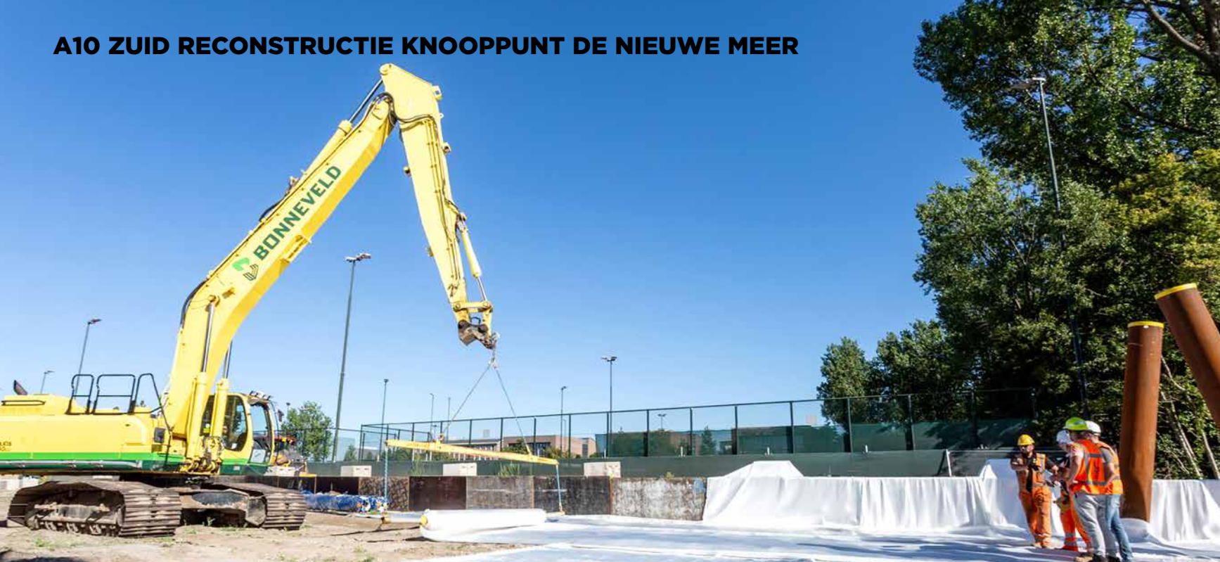
Het paalmatras wordt door Bonneveld Gewapende Grondconstructies zorgvuldig opgebouwd.
