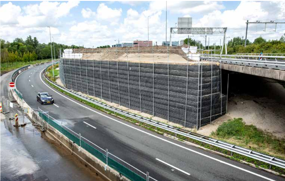
De realisatie van de paalmatras- en gewapende grondconstructies bij knooppunt De Nieuwe Meer is een technisch én logistiek hoogstandje.
