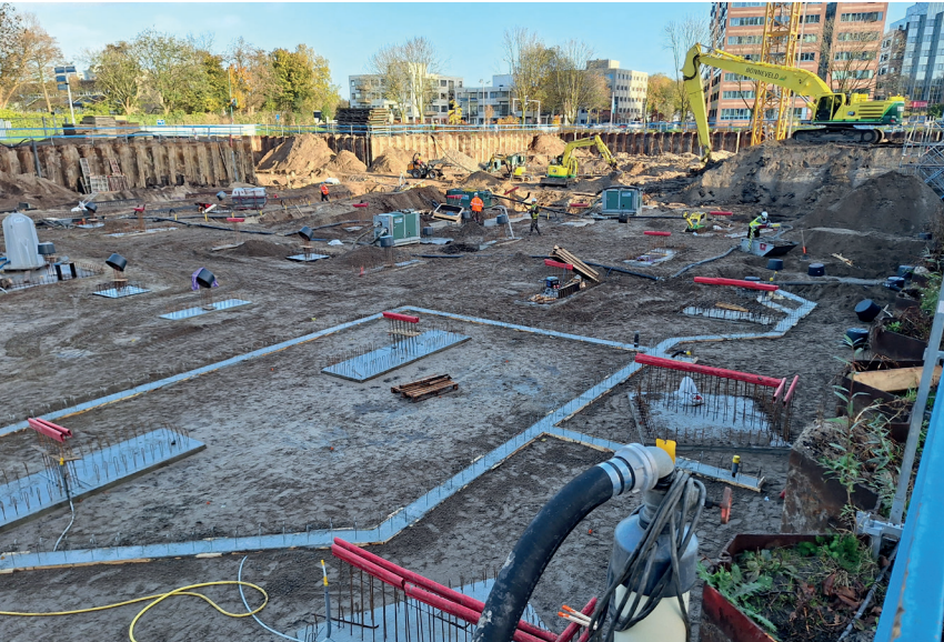
De bouwkuip had een omvang van ongeveer 130 bij 80 meter.
