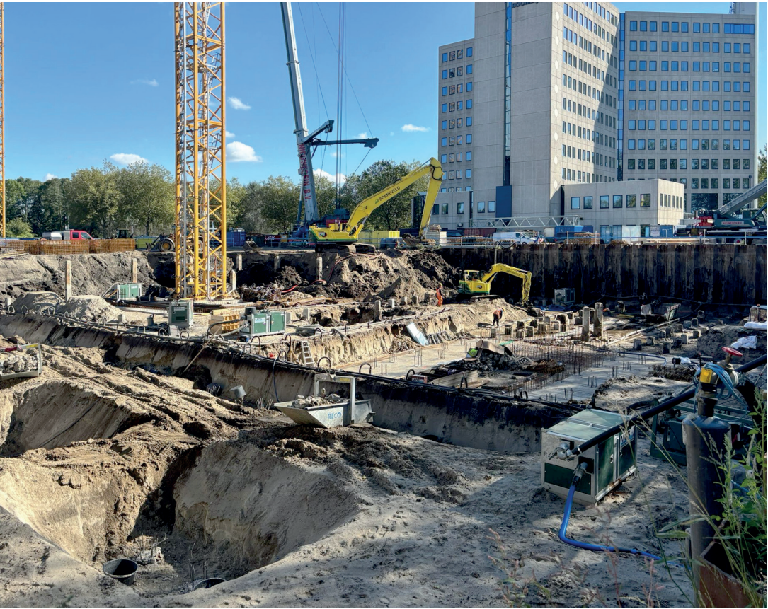
Voor het uitgraven heeft Bonneveld gebruik gemaakt van een 45-tons long reach kraan in combinatie met een 9-tons minigraver in de kuip.
