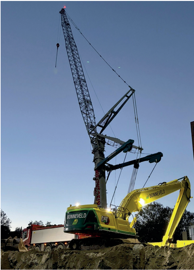
Zand, klei en veen zijn zorgvuldig gescheiden ontgraven en naar verschillende locaties afgevoerd.
